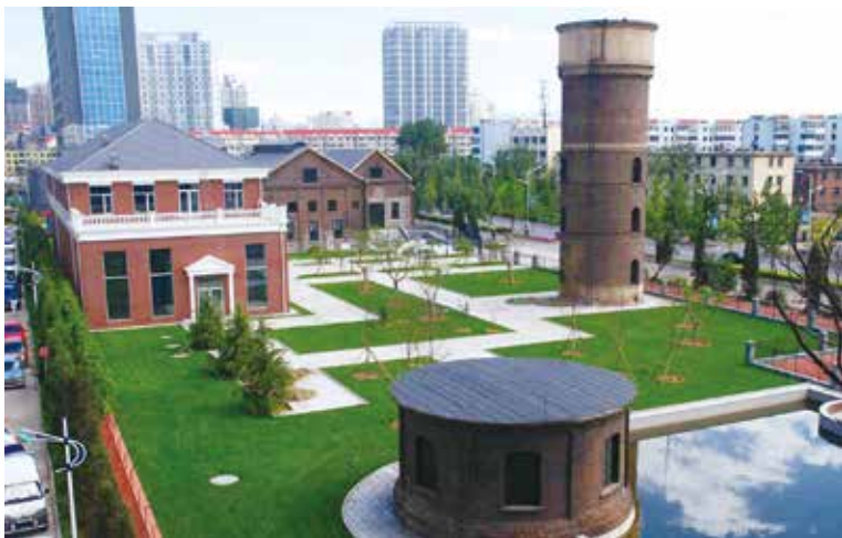
依托耀华玻璃厂原址（1922年建设的厂房、水塔和泵房）建成我国第一家国有玻璃专题博物馆——秦皇岛市玻璃博物馆。
