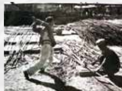
1954年, 永登水泥厂建设场景
