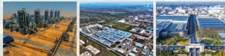
2018年5月，埃及GOE6条水泥生产线项目 2021年9月，中复神鹰西宁万吨碳纤维生产基地 2022年11月，中国巨石建成玻纤行业世界第一智能制造基地
