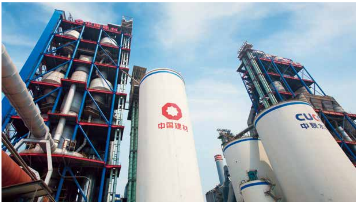
徐州中联双万吨水泥生产线
